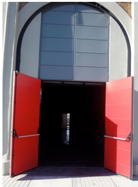
Puerta de carga
