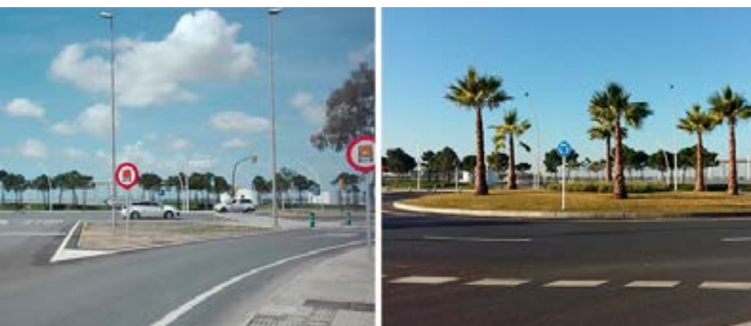
Glorieta de la Avenida Francisco Montenegro (antes y después de las obras)
