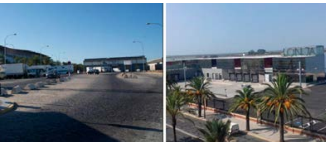
Nueva Lonja Pesquera (antes y después de las obras)
