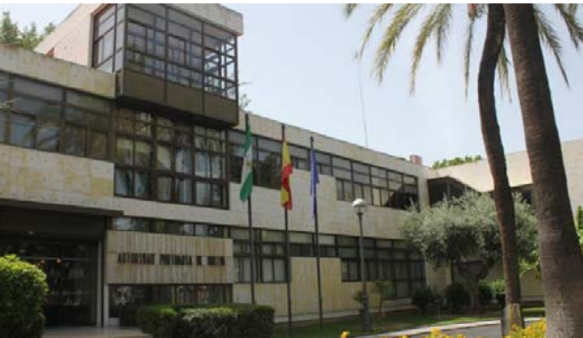
Oficinas de la Autoridad Portuaria de Huelva
