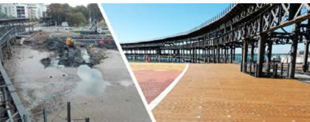
~~~~~ Ordenación entorno del Cargadero de Riotinto (antes y después de las obras)
