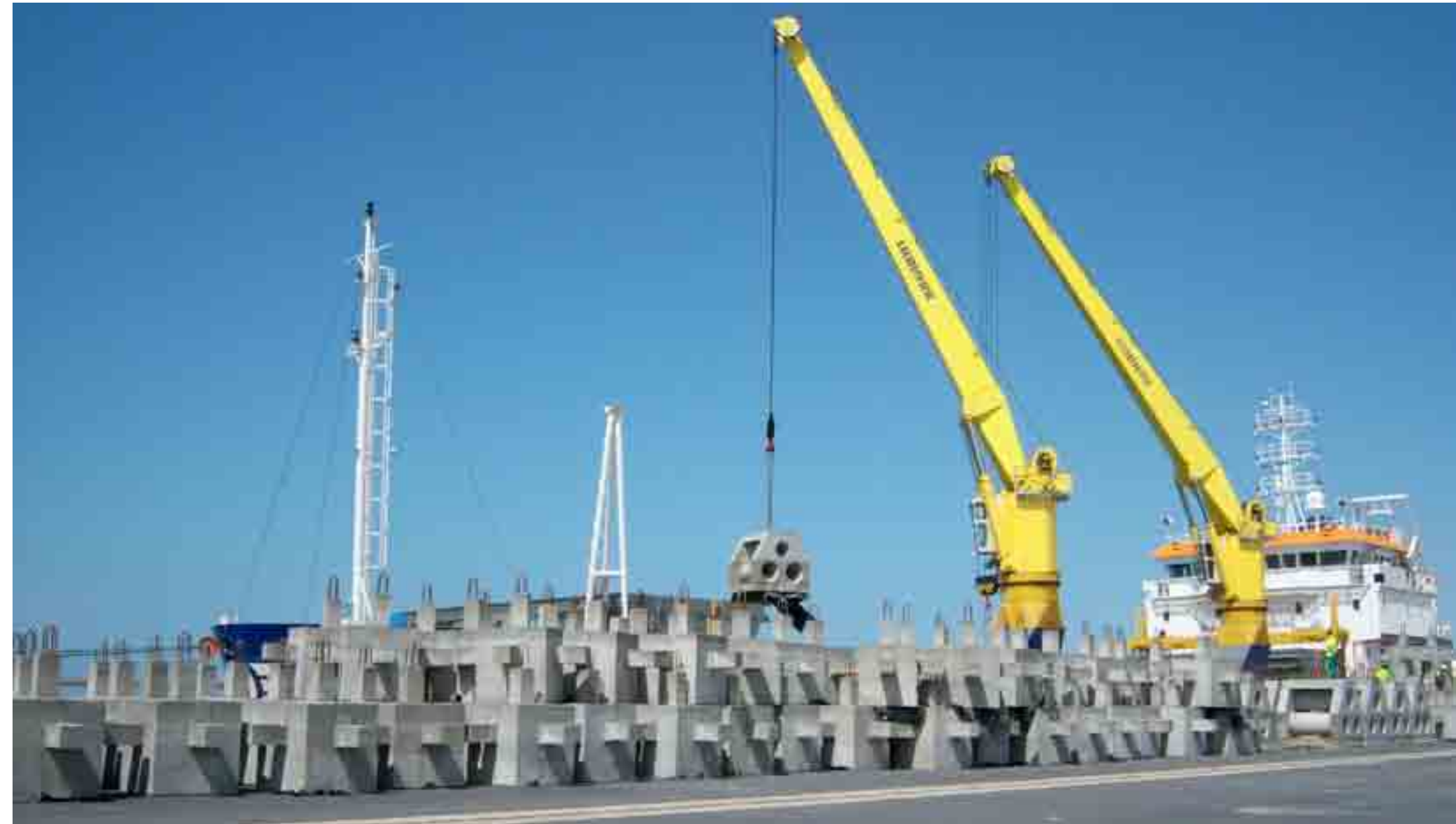
Carga de arrecifes artificiales en el Muelle Sur.
