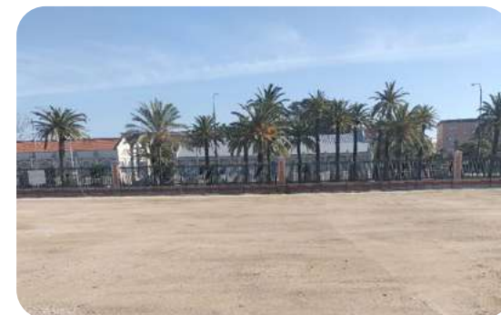
Demolición del último módulo (durante las obras).
