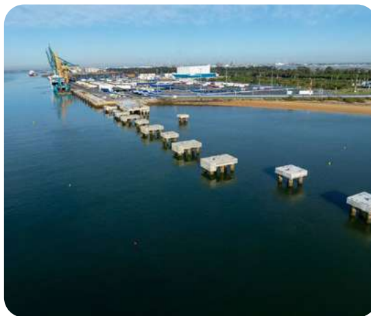
Nueva plataforma Ro-Ro (durante las obras).
