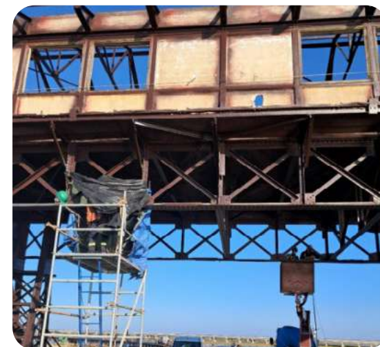
Reparación de oficina puente (durante las obras).
