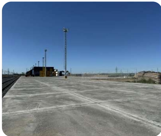
Ampliación terminal Majarabique (finalización de las obras).
