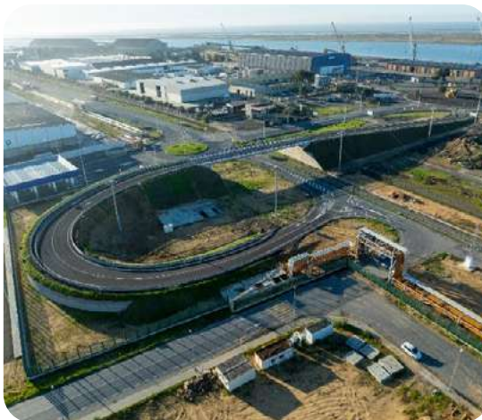
Obra del acceso único.
